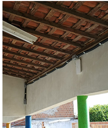
Cabeamento interno e Access Points
