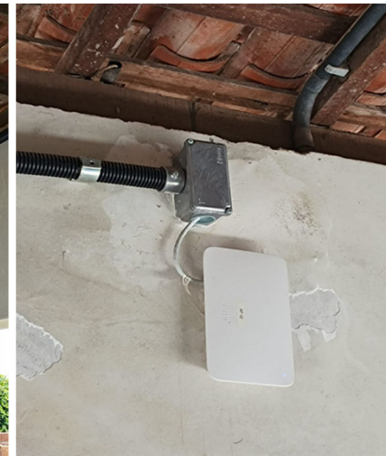
Cabeamento interno e Access Points
